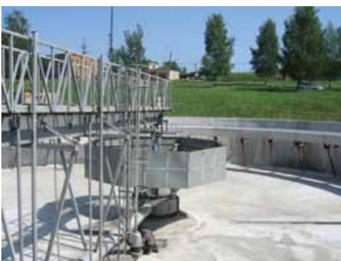
Очистные сооружения, г. Чехов
